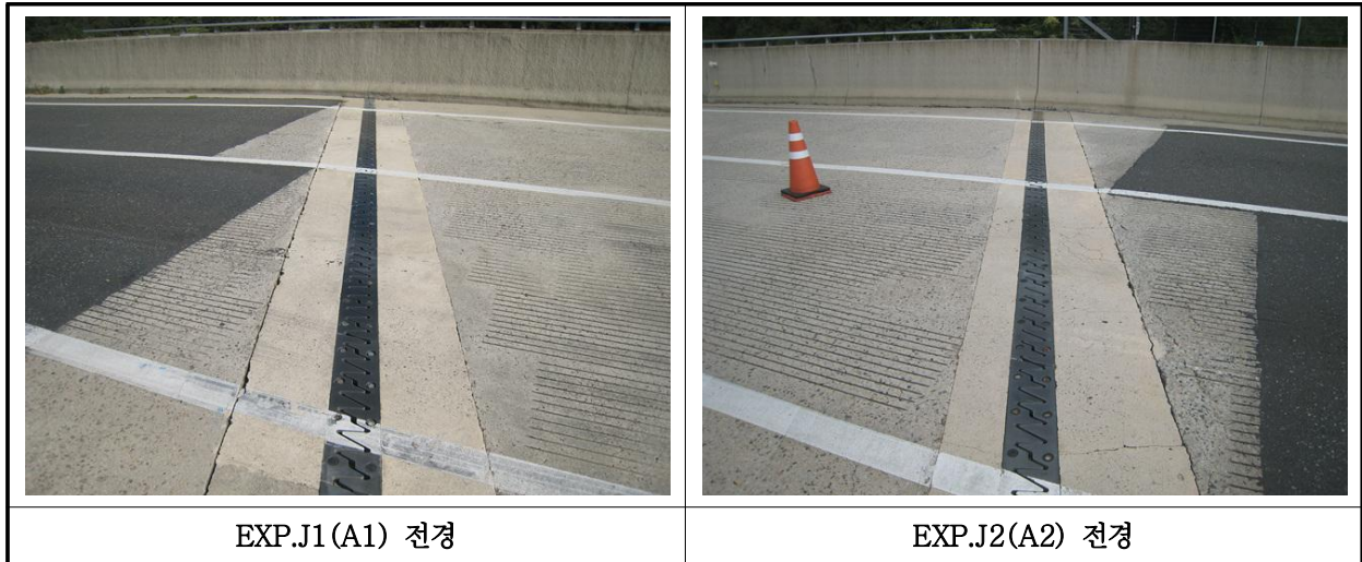
【사진 23.3.44】 신축이음장치 전경
