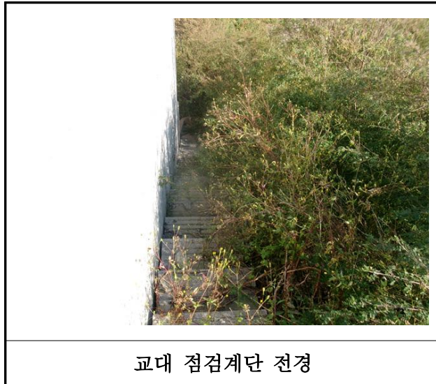
【사진 23.3.53】 교량 점검시설 전경
