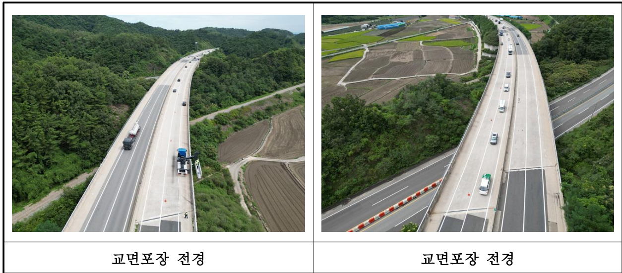
【사진 23.3.47】 교면포장 전경
