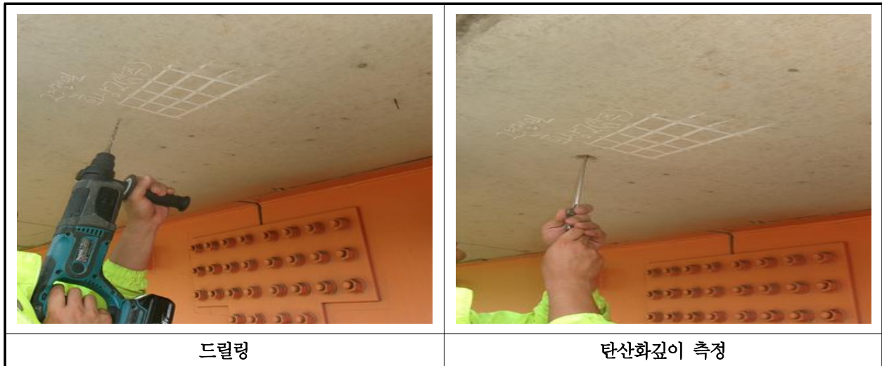
【사진 23.4.3】 탄산화 깊이 측정 현장사진
