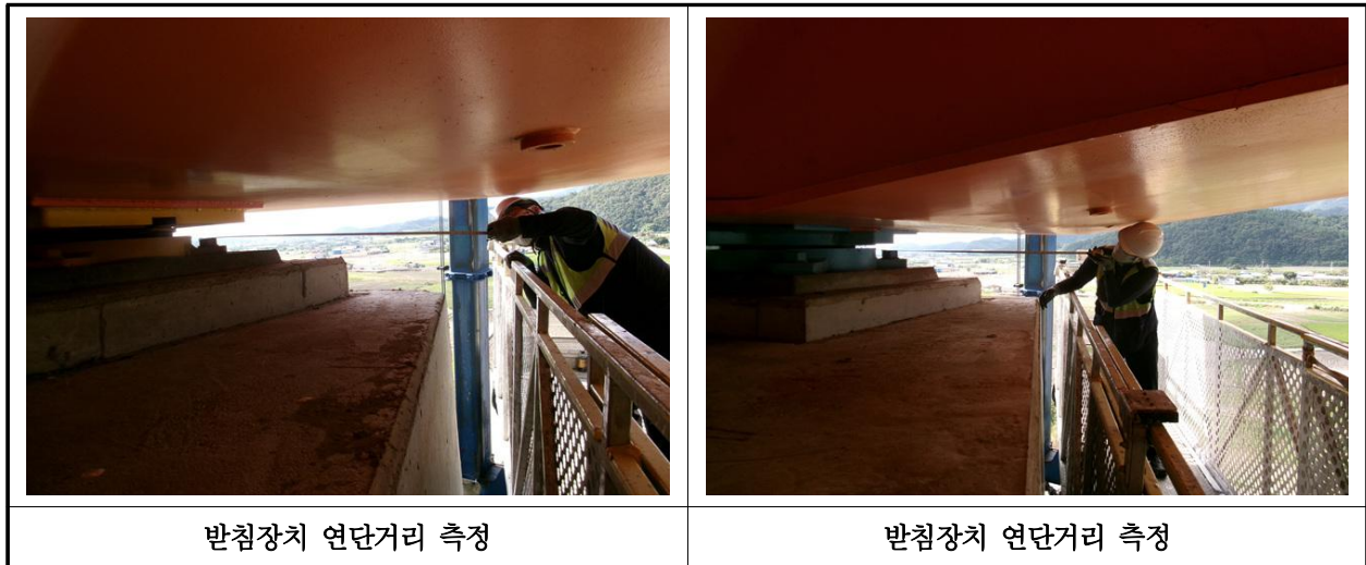
【사진 23.3.42】 교량반침장치 연단거리측정
