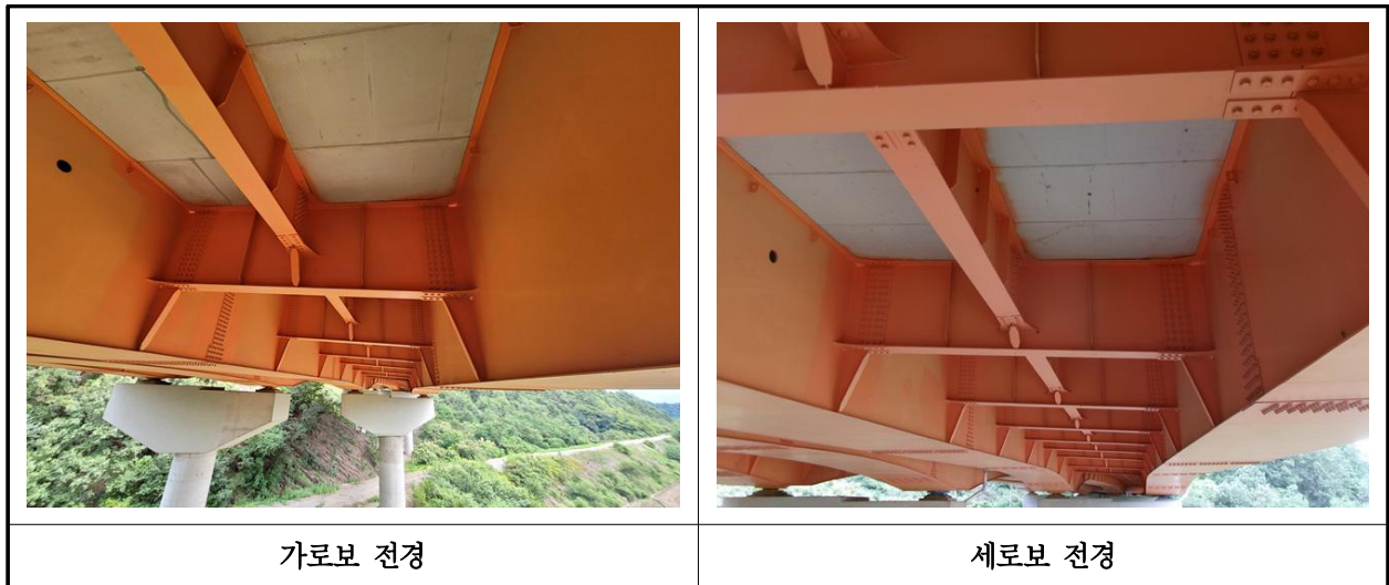
【사진 23.3.33】 가로보 및 세로보 전경
