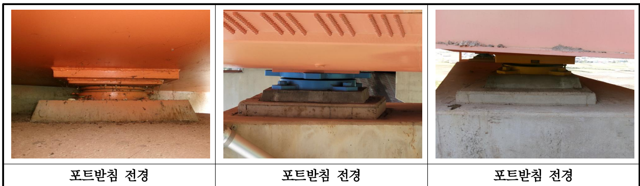
【사진 23.3.13】 교량반침 전경
