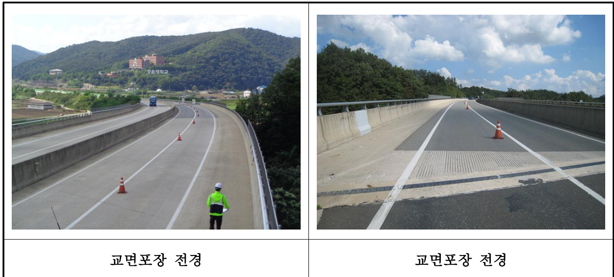
【사진 23.3.20】 교면포장 전경
