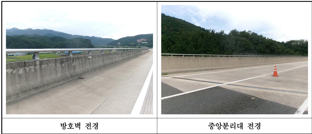
【사진 23.3.51】 방호벽 및 중앙분리대 전경
