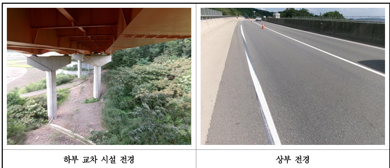
【사진 23.2.1】 부재 현장측정 전경
