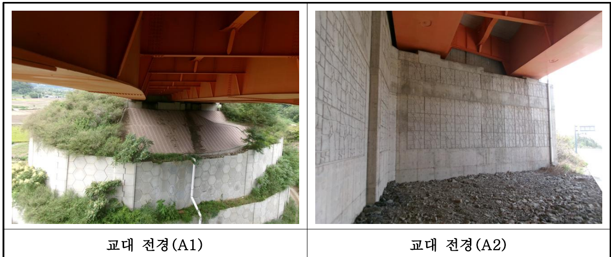
【사진 23.3.35】 교대 전경
