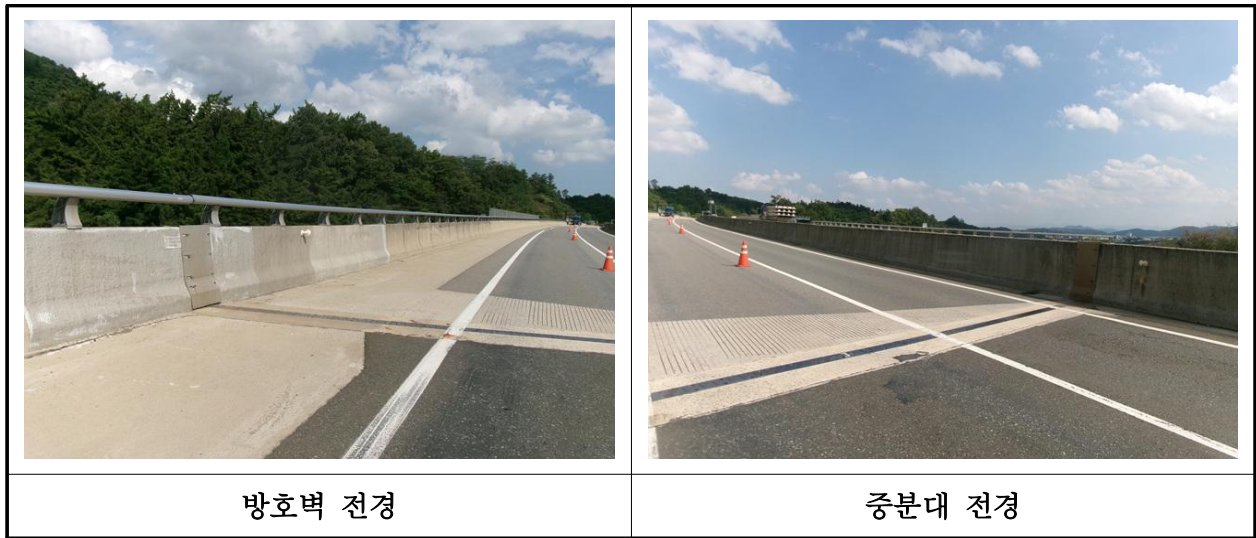
【사진 23.3.24】 방호벽 및 중앙분리대 전경
