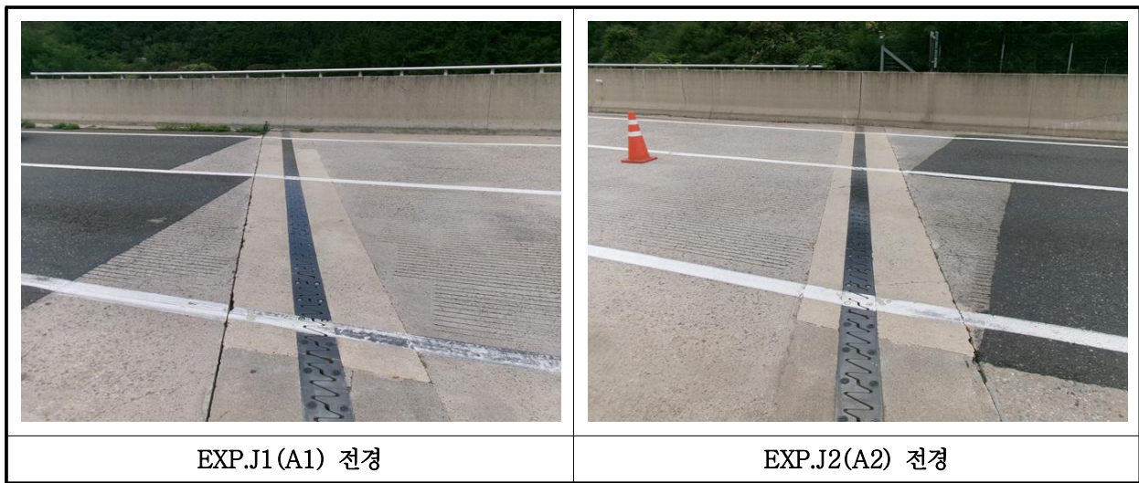
【사진 23.3.17】 신축이음장치 전경
