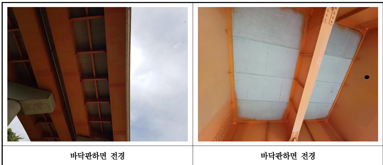
【사진 23.3.29】 바닥판하면 전경
