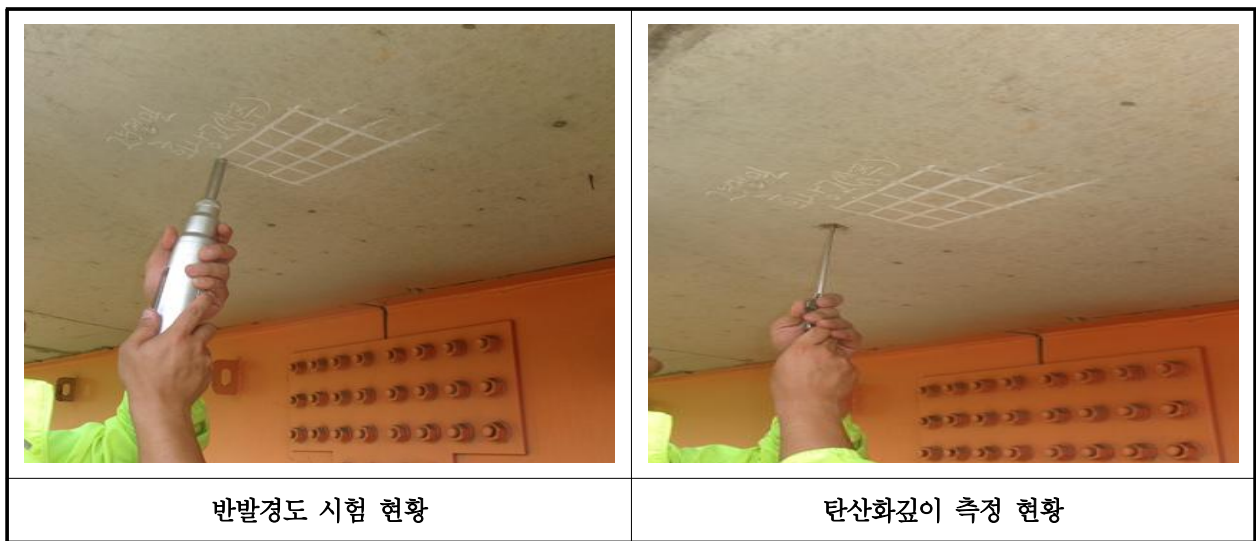
【사진 23.4.1】 콘크리트 내구성조사 현황
