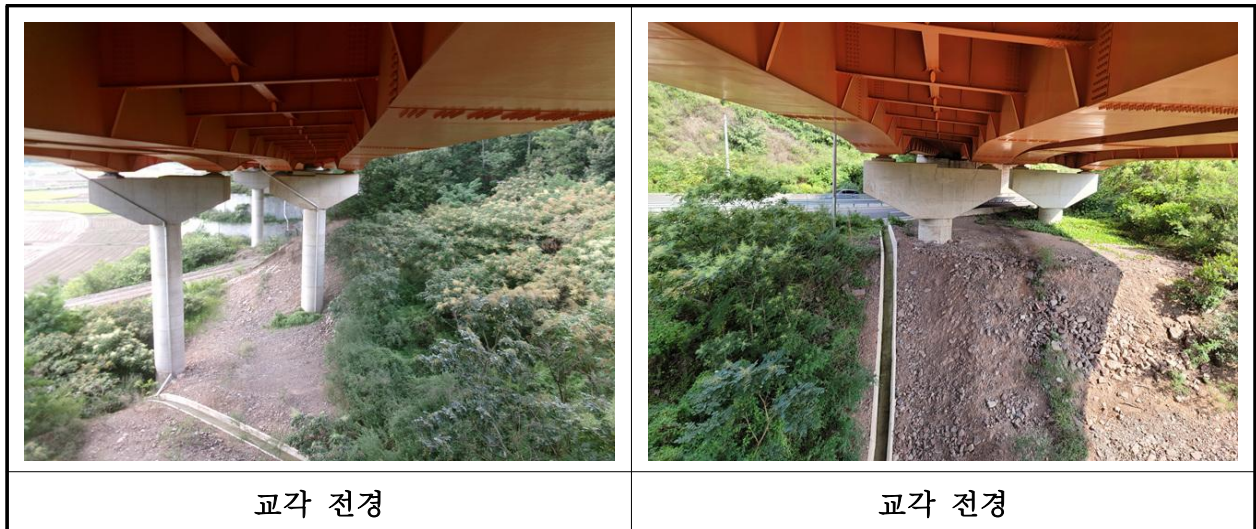
【사진 23.3.10】 교각 전경
