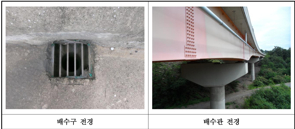
【사진 23.3.49】 배수시설 전경
