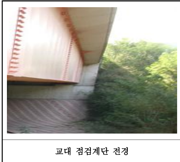
【사진 23.3.26】 교량 점검시설 전경
