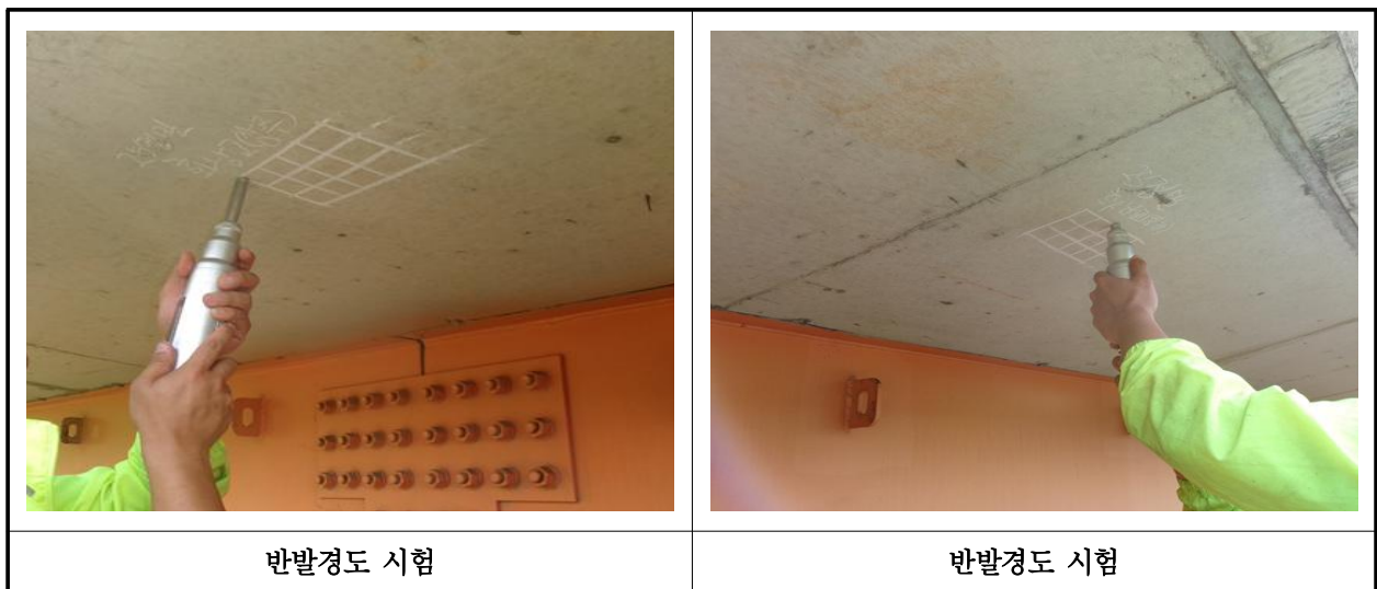
【사진 23.4.2】반발경도시험 현장사진
