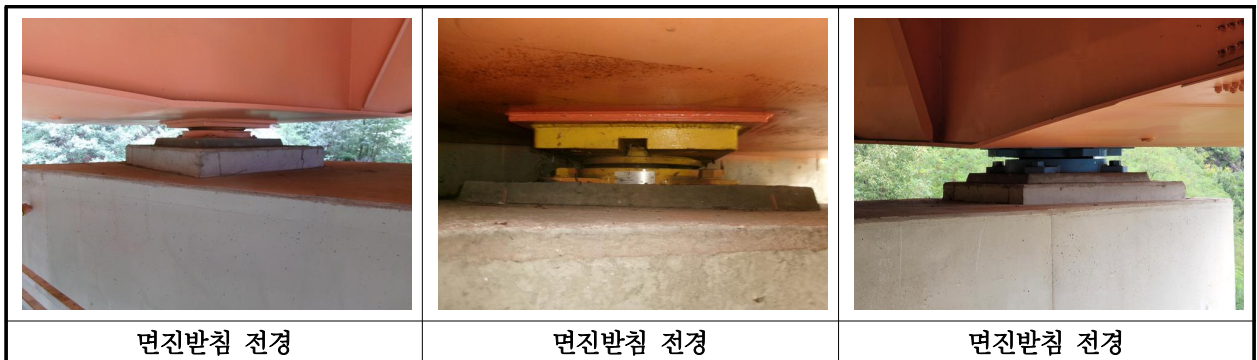
【사진 23.3.40】 교량반침 전경
