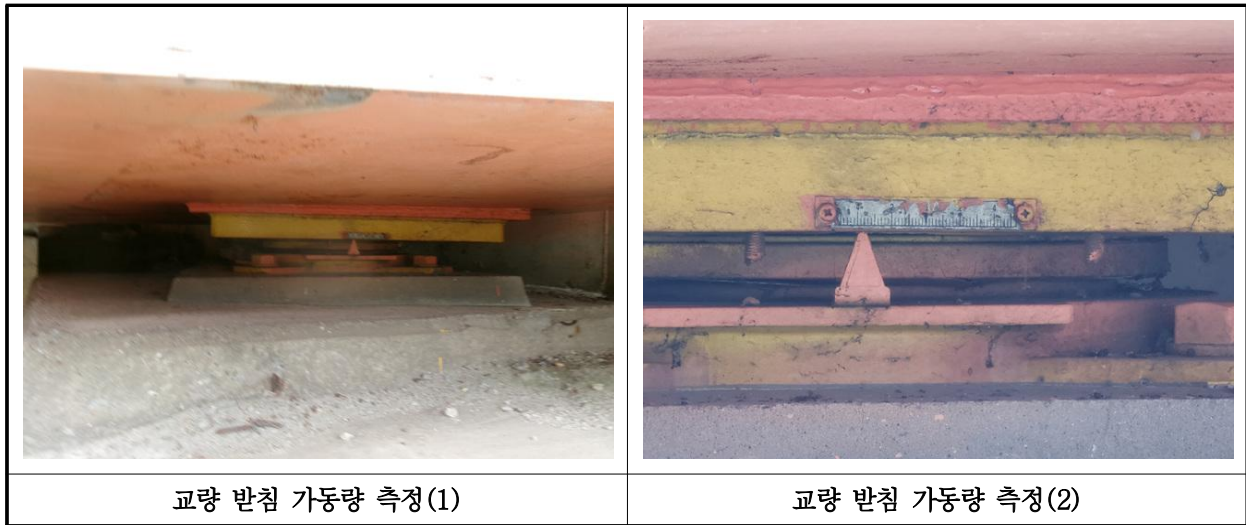
【사진 23.3.43】 교량받침 이동량 측정
